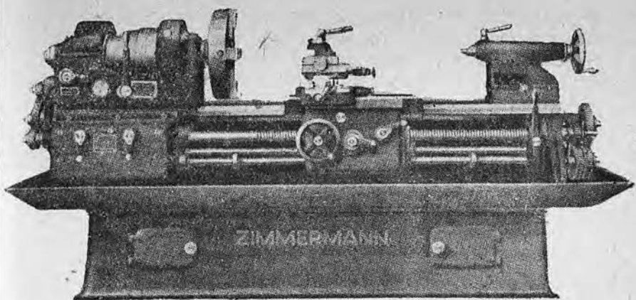
Рис. 1. Универсальный токарный станок.
