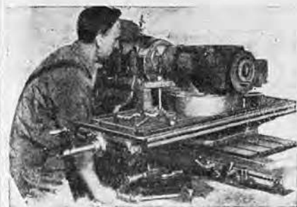
Рис. 26. Подводка детали к шлифовальному кругу
