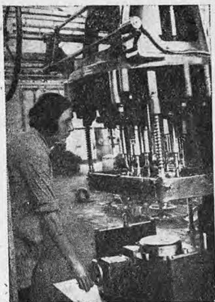
Рис. 42. Многошпиндельный сверлильный станок.
